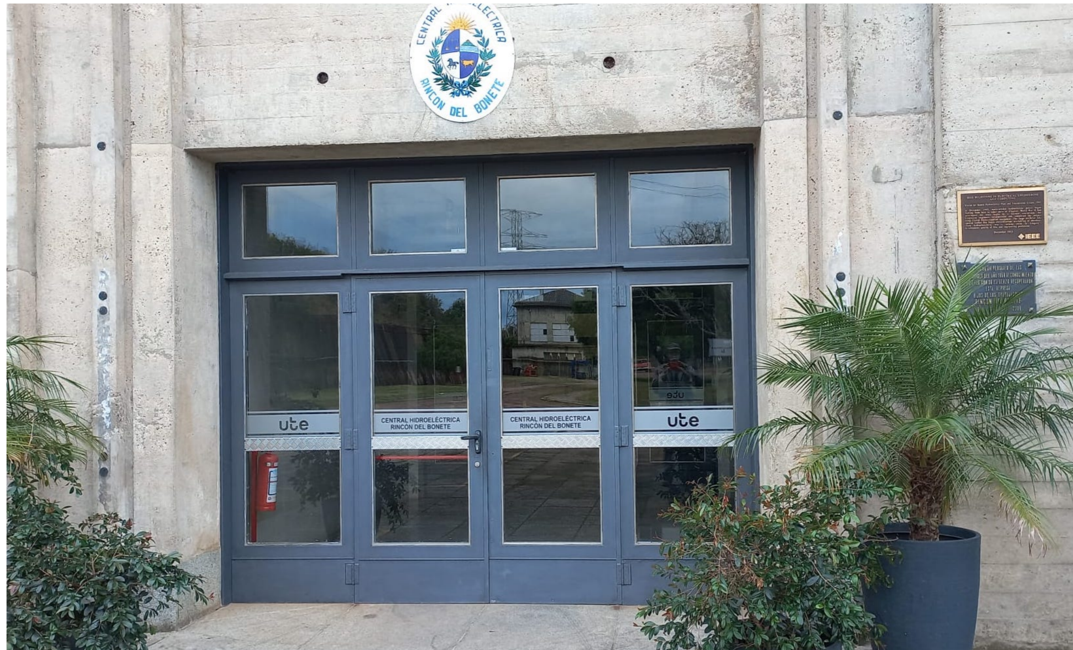
Puerta de entrada a la central Bonete, vista actual con la placa
